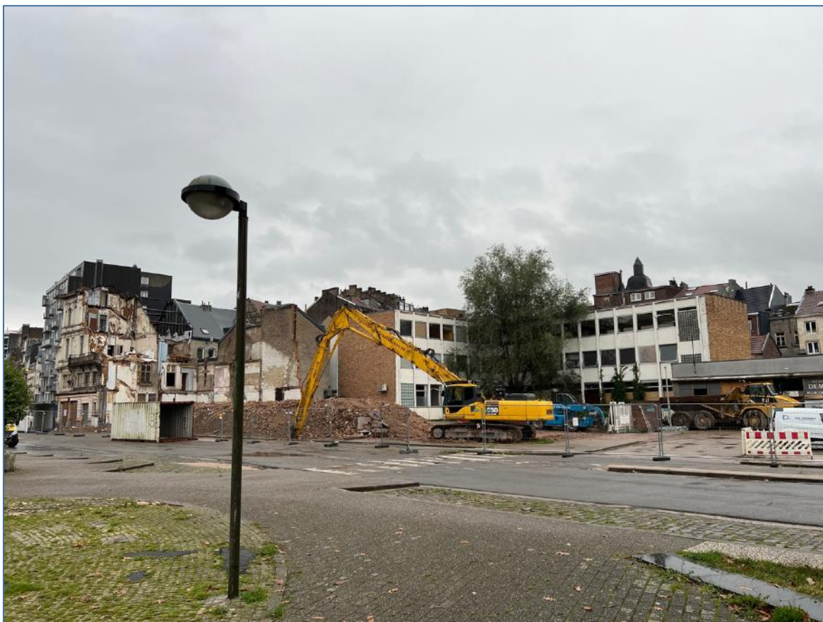
Vue depuis la rue du Marteau vers le sud-est
