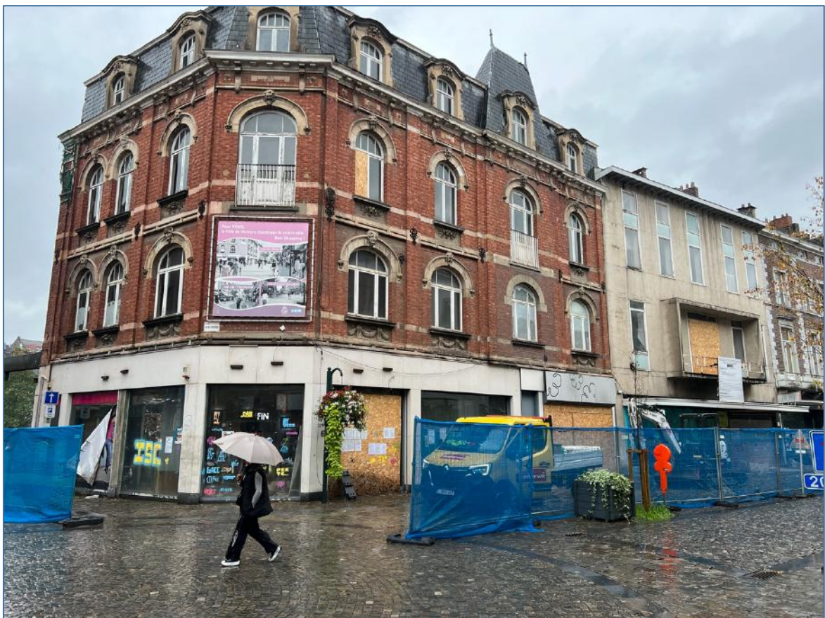
Vue sur les immeubles restant à démolir rue du Brou (au coin avec la rue Henri Hurard)
