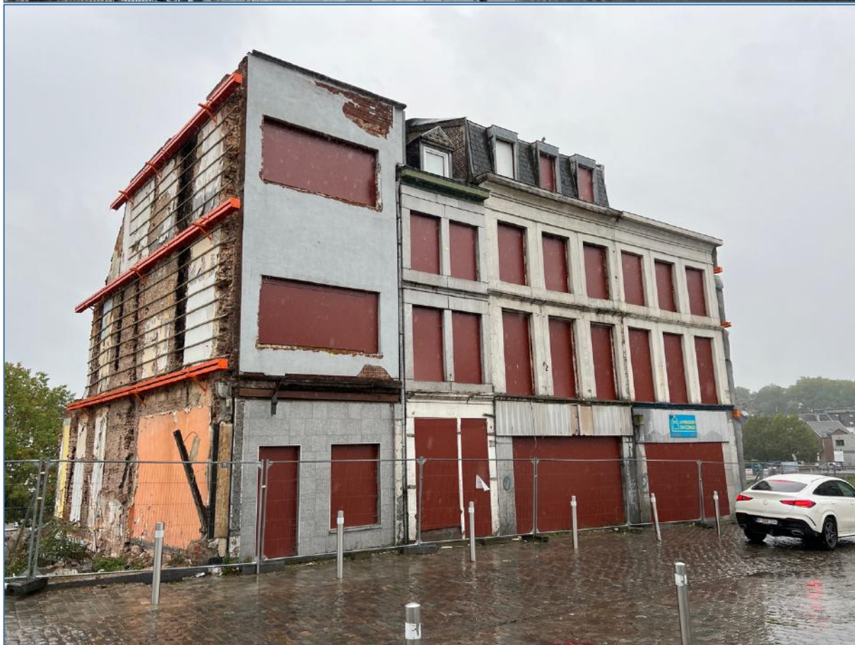
Vues sur la rue Spintay et les quelques bâtiments restant à démolir
