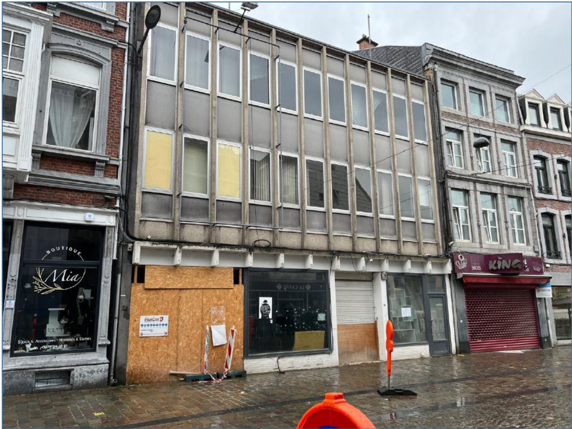
Vue sur l'immeuble à démolir donnant rue Pont Saint-Laurent (N°25/27)
