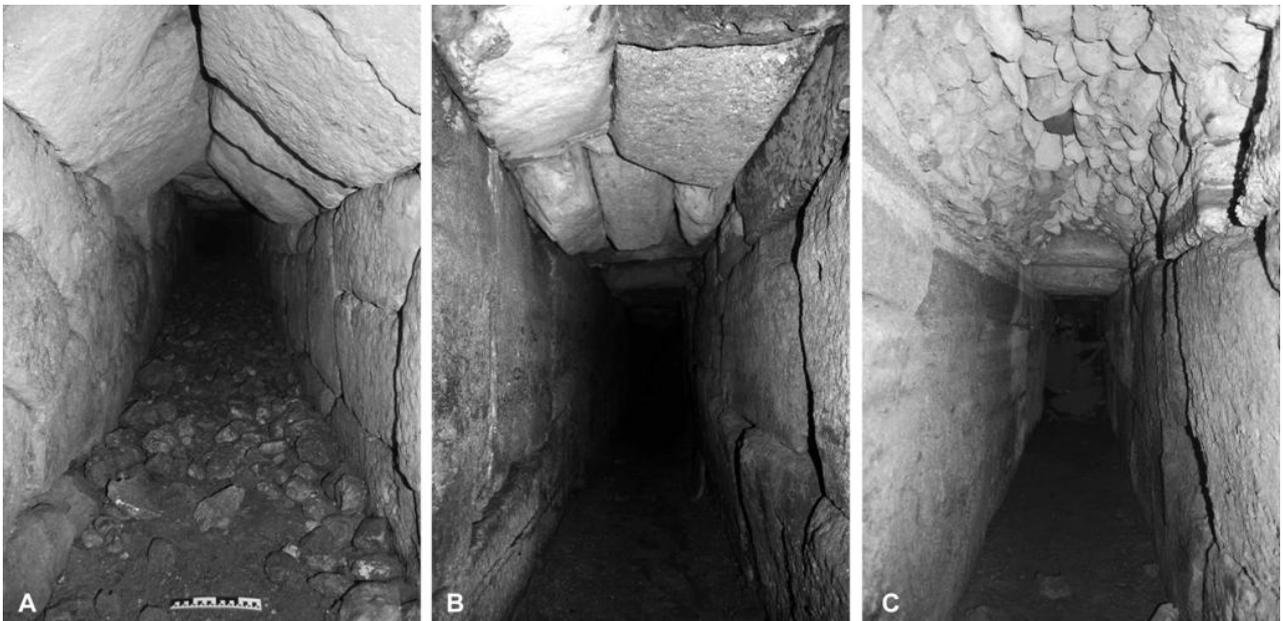
Fig. 22. Exemples de couvertures atypiques. A. Couverture en bâtière dans un diverticule du collecteur principal. B. Couverture voûtée de gros blocs dans la branche ouest du collecteur sous le *macellum*. C. Couverture voûtée maçonnée dans cette même branche du collecteur.
