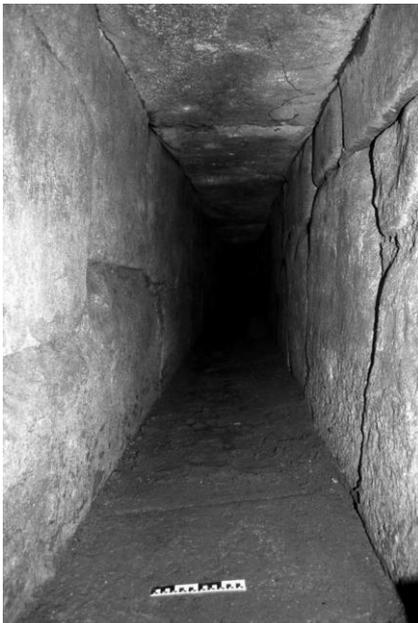
La pente des égouts est variable, jusqu'à 60% dans un diverticule du collecteur sud descendant la colline de San Pietro (fig. 13, A). Des marches et des ressauts du plafond sont fréquents, adaptant la profondeur de la galerie à la topographie en surface. Certaines sections d'égouts ont une hauteur sous plafond plus élevée que d'autres, sans que la raison en soit toujours évidente.
